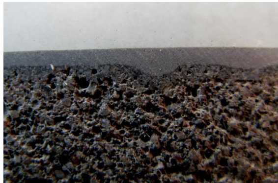
Betonbeschichtung für Biogasanlage (Querschliff)
